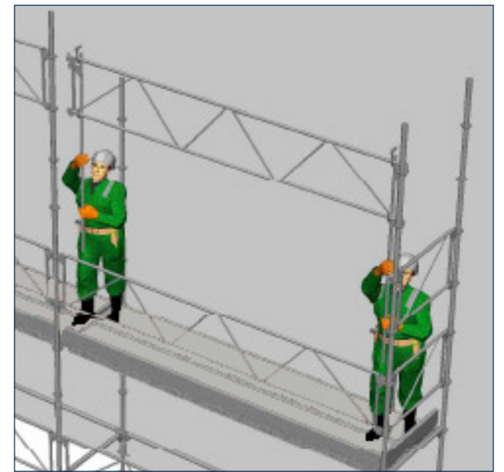
Hvert rækværk løftes af 2 opstillere (en ved hver ende).
